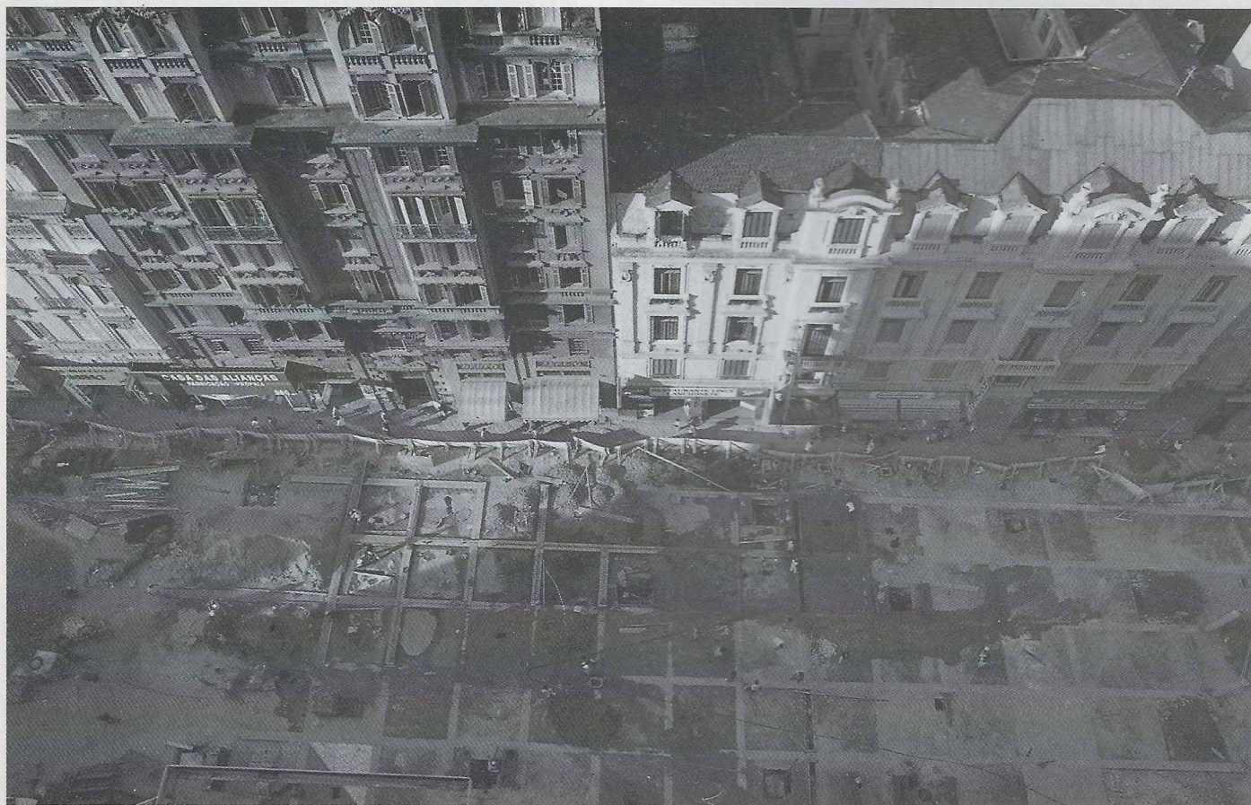
AVENIDA SÃO JOÃO
